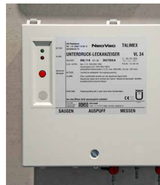
Indicatore di perdite a depressione LV34
