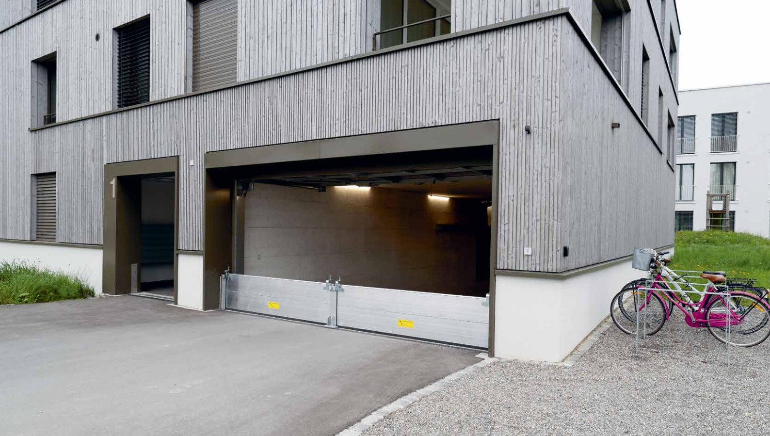
Sistemi di protezione dalle piene
