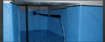
Das Wasser läuft wieder! Nach der Sanierung wird das Reservoir neu gefüllt.
