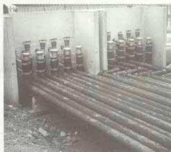
Installation der Fernfülleleitungen von Tanks bis Füllschacht
