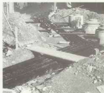
Installation der Fernfülleleitungen von Tanks bis Füllschacht
