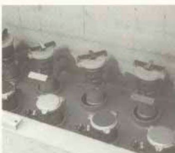
Fertiggestellter Fernfüllschacht mit Gaspendelung
