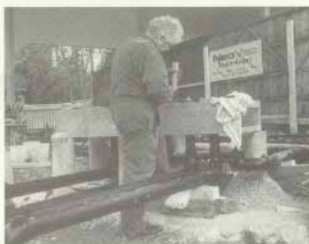
Verröhrung für Zapfstäulen
