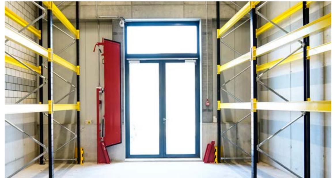
La barrière de retenue d'eau d'extinction d'incendie semi-automatique installée dans la zone de stockage garantit une sécurité maximale.
