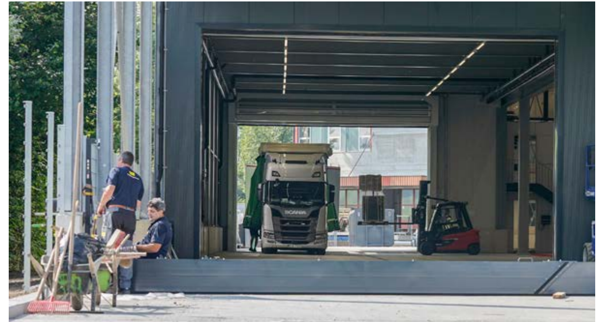
Montaggio preciso al millimetro: installazione di una paratia per acqua a uso antincendio semiautomatica, adattata al meglio alle condizioni strutturali.
