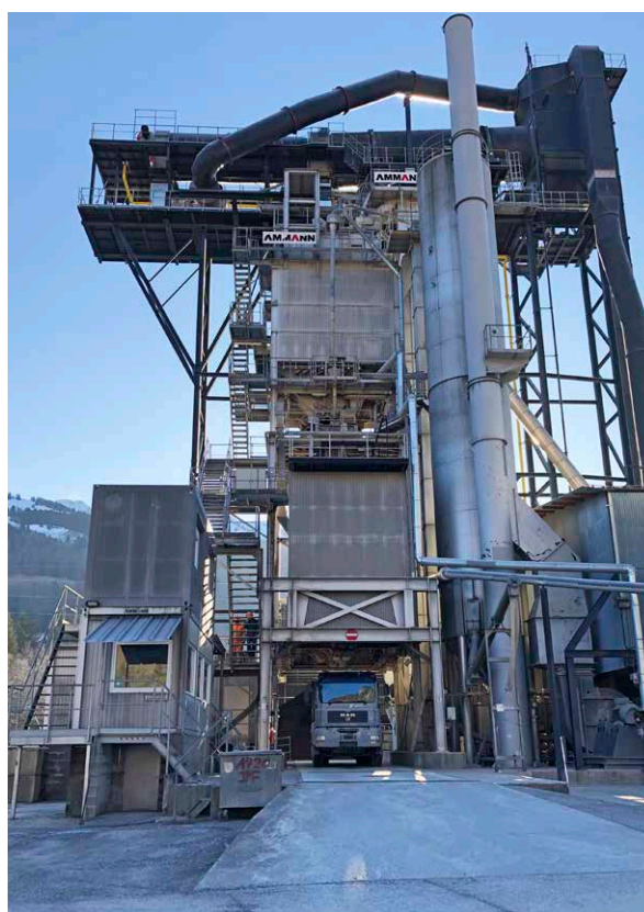
Impianto per la produzione di asfalto con approvvigionamento di combustibile completo e punto di rifornimento di asfalto liquido per il riempimento dei camion.
