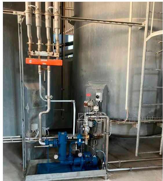
Nuova stazione delle pompe di alimentazione con condotti di prelievo per i due serbatoi di stoccaggio e linee di trasferimento ai bruciatori.
