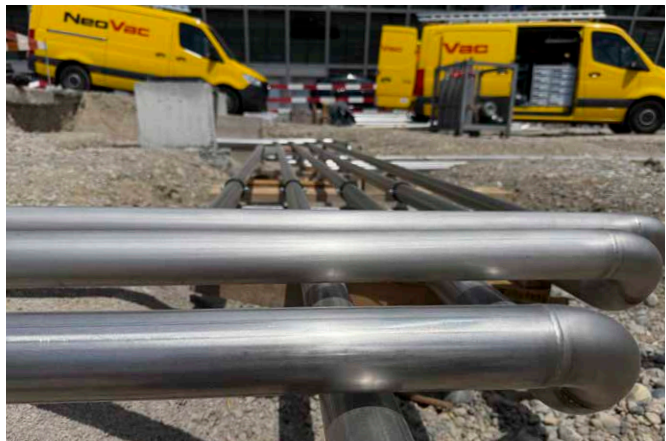
Präzise verlegte Treibstoff- und Fernfüllleitungen.
