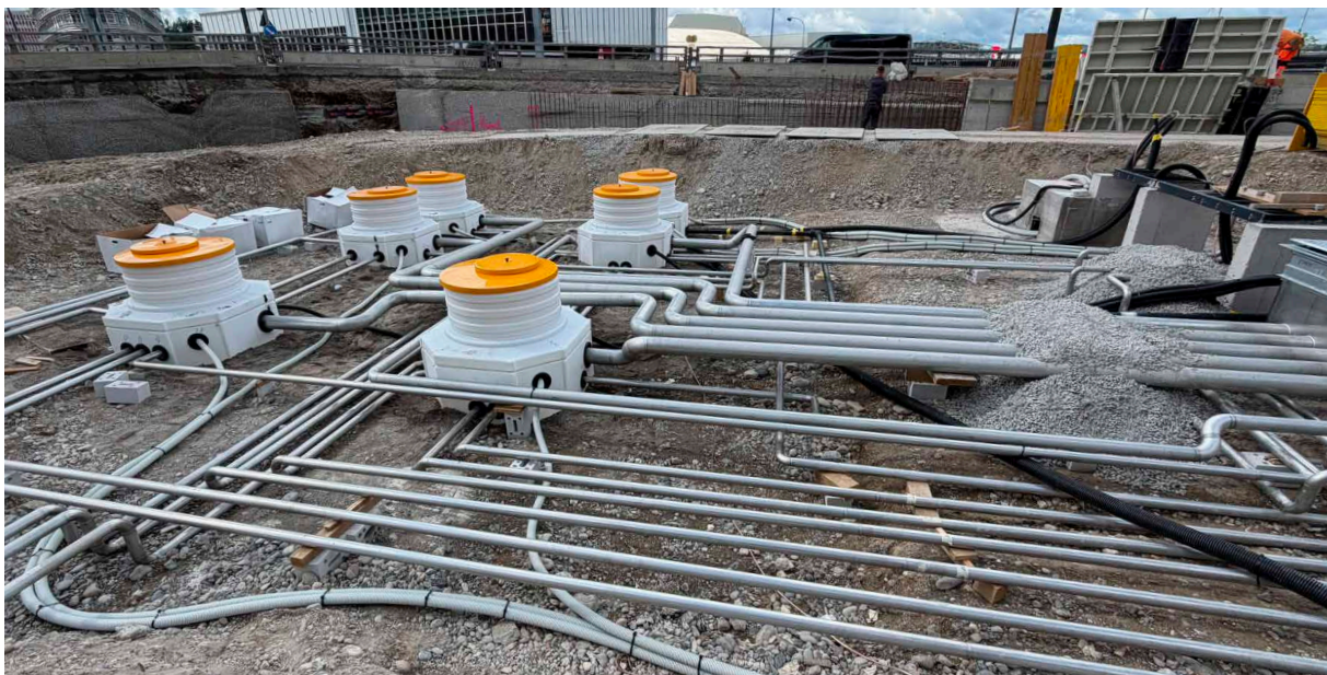
Fertig verlegte Treibstoff- und Fernfüllleitungen vor den weiteren Bauarbeiten.
