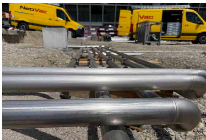
Conduites de carburant et de remplissage à distance posées avec précision.
