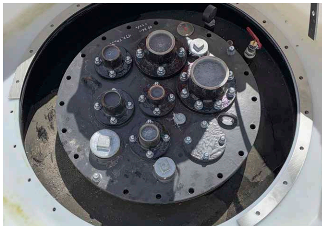
Raccordi nel pozzetto di accesso, predisposti per il successivo collegamento ai serbatoi di stoccaggio interrati.
