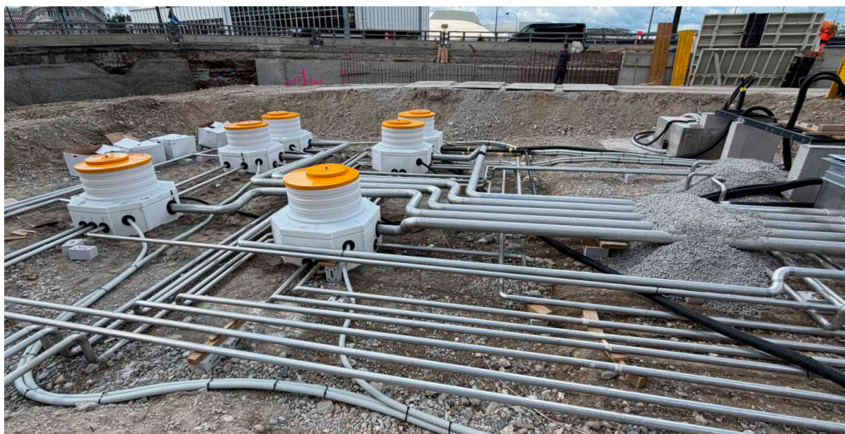
Condutture per il carburante e il riempimento a distanza completamente posate, prima dell'avvio delle successive fasi del cantiere.
