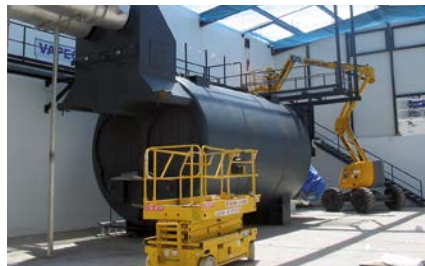
Tagestank bei der Montage
