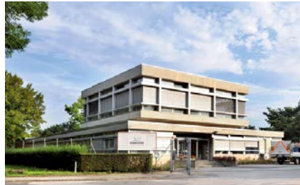
Kläranlage STEP de Vidy
