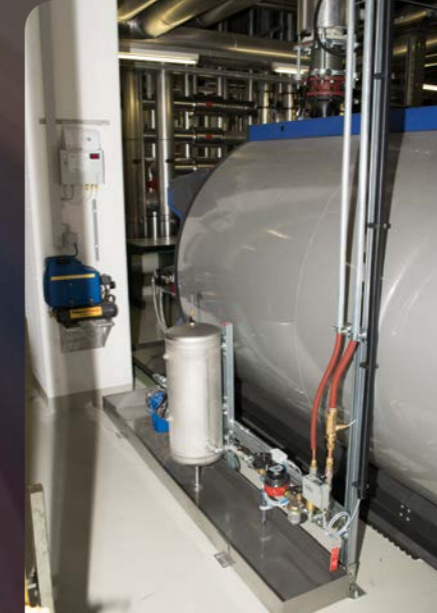
Costruzione dell'impianto con vasca di raccolta
