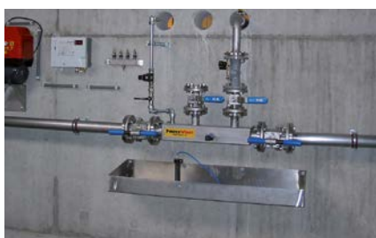
Condotte per il rifornimento d'olio in acciaio cromato
