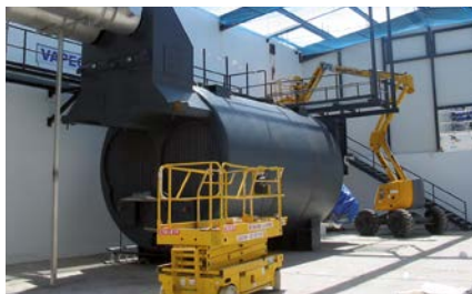
Serbatoio giornaliero durante il montaggio
