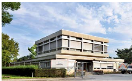
Impianto di depurazione STEP de Vidy
