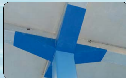
Pilastro rivestito con placche in PE
