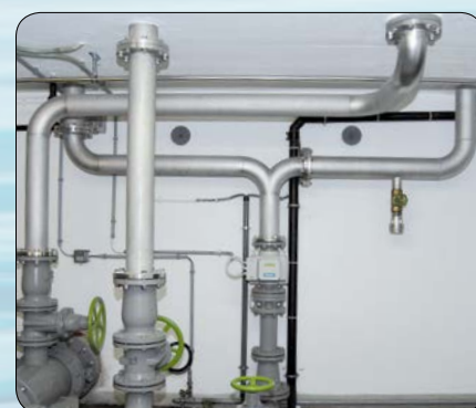
Costruzione di tubazioni in acciaio cromato realizzata dagli specialisti NeoVac
