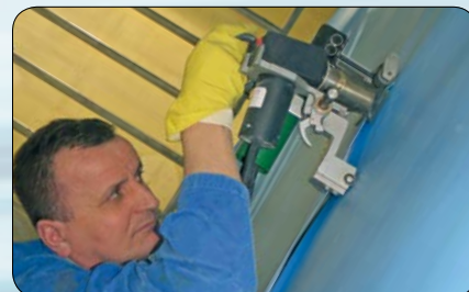
Montaggio del manto di impermeabilizzazione
