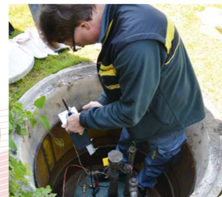
Il tecnico di assistenza collega la sonda di misura con la centralina di calcolo e comunicazione.
