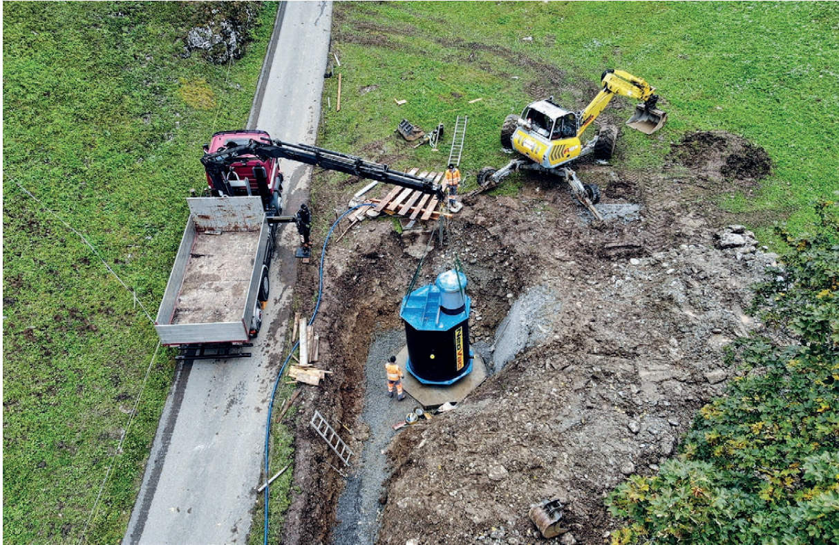
Ablad eines Armaturenschachtes direkt in die vorbereitete Baugrube
