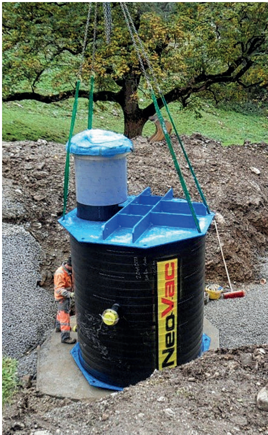
Ausrichten und Stellen des Behälters
