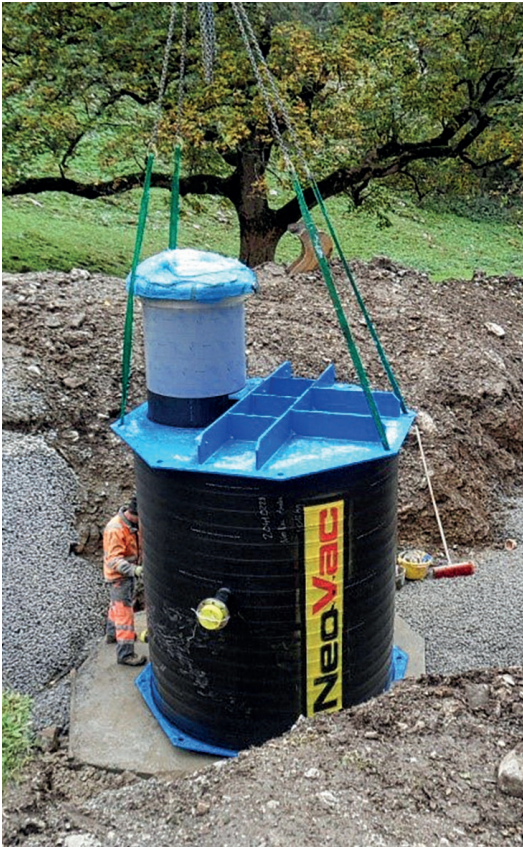
Alignement et mise en place du réservoir
