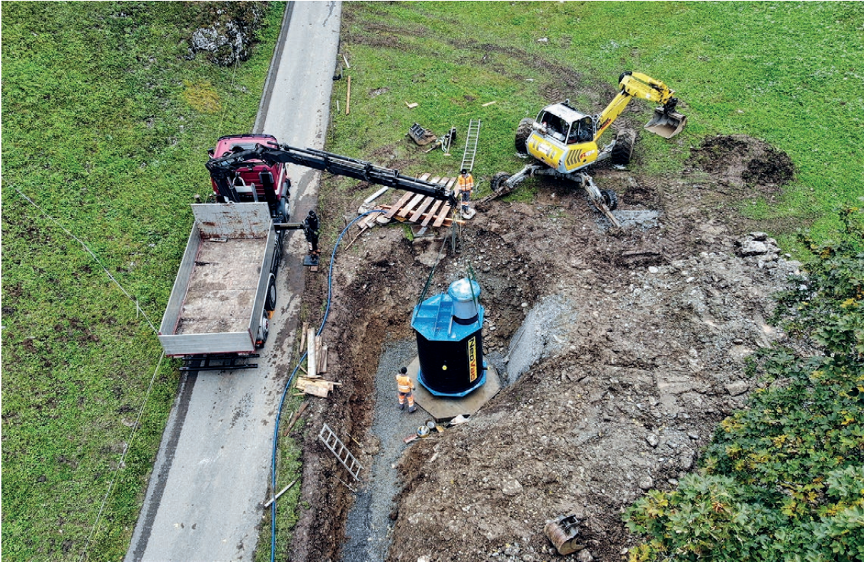
Déchargement d'une chambre pour vannes directement dans l'excavation préparée
