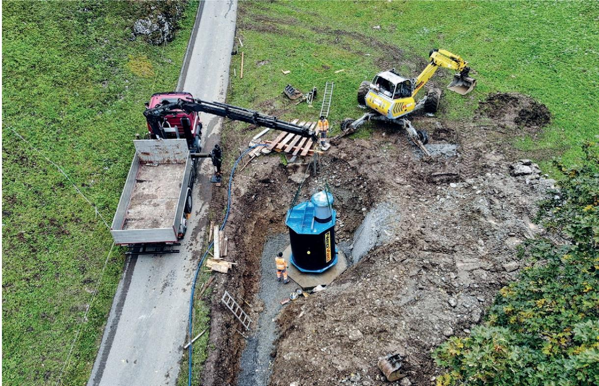
Scarico di un pozzetto valvole direttamente nello scavo predisposto
