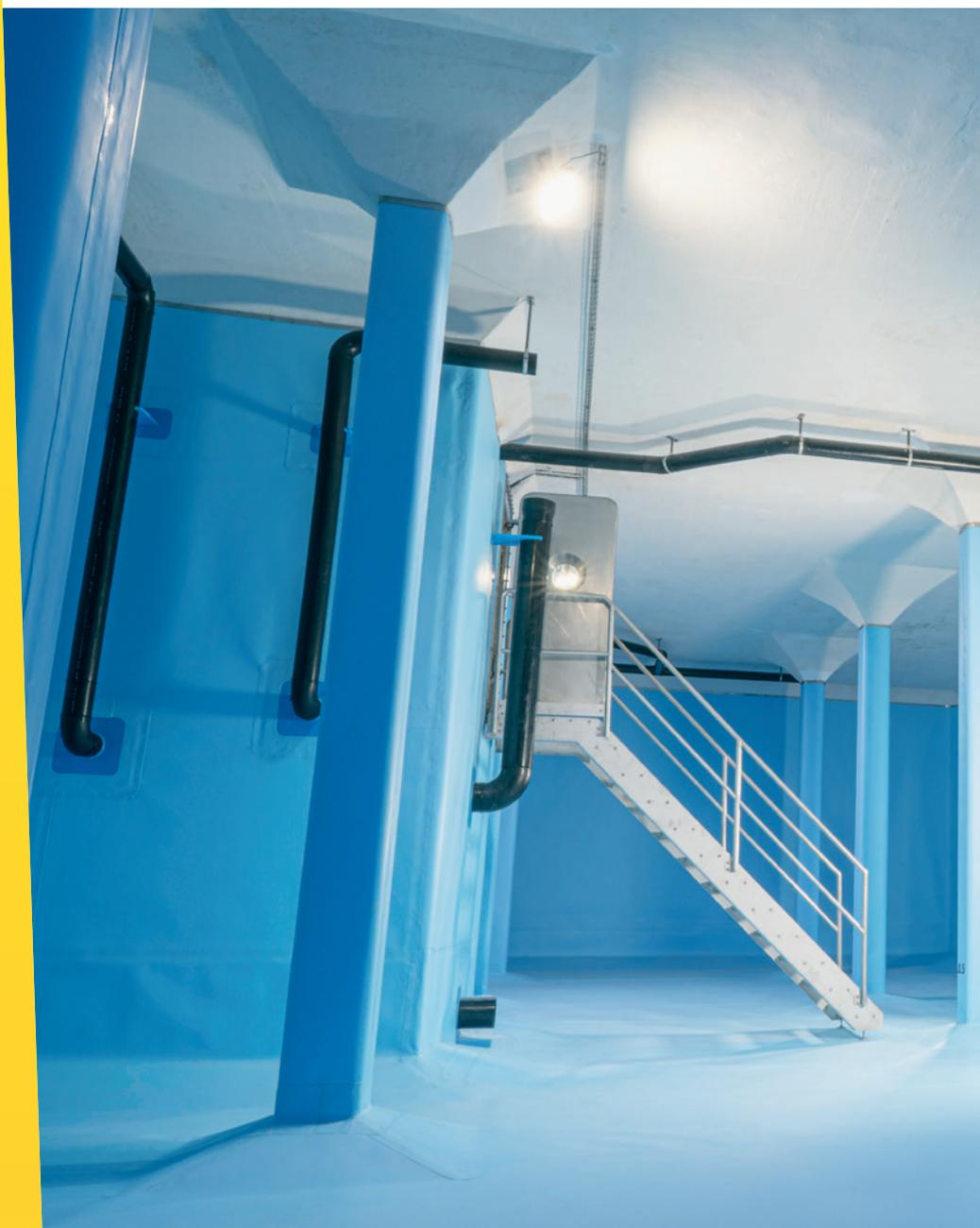
adaptant les conduites à l'intérieur de la chambre à eau. Suite à des problèmes avec le sous-sol minéral, le réseau de distribution d'eau de Birmensdorf s'est adressé à NeoVac SA. Le film pour eau potable en polyéthylène (PE) s'est avéré la solution idéale pour l'assainissement du réservoir, car ce système offre une séparation complète entre l'eau potable et le sous-sol existant.
