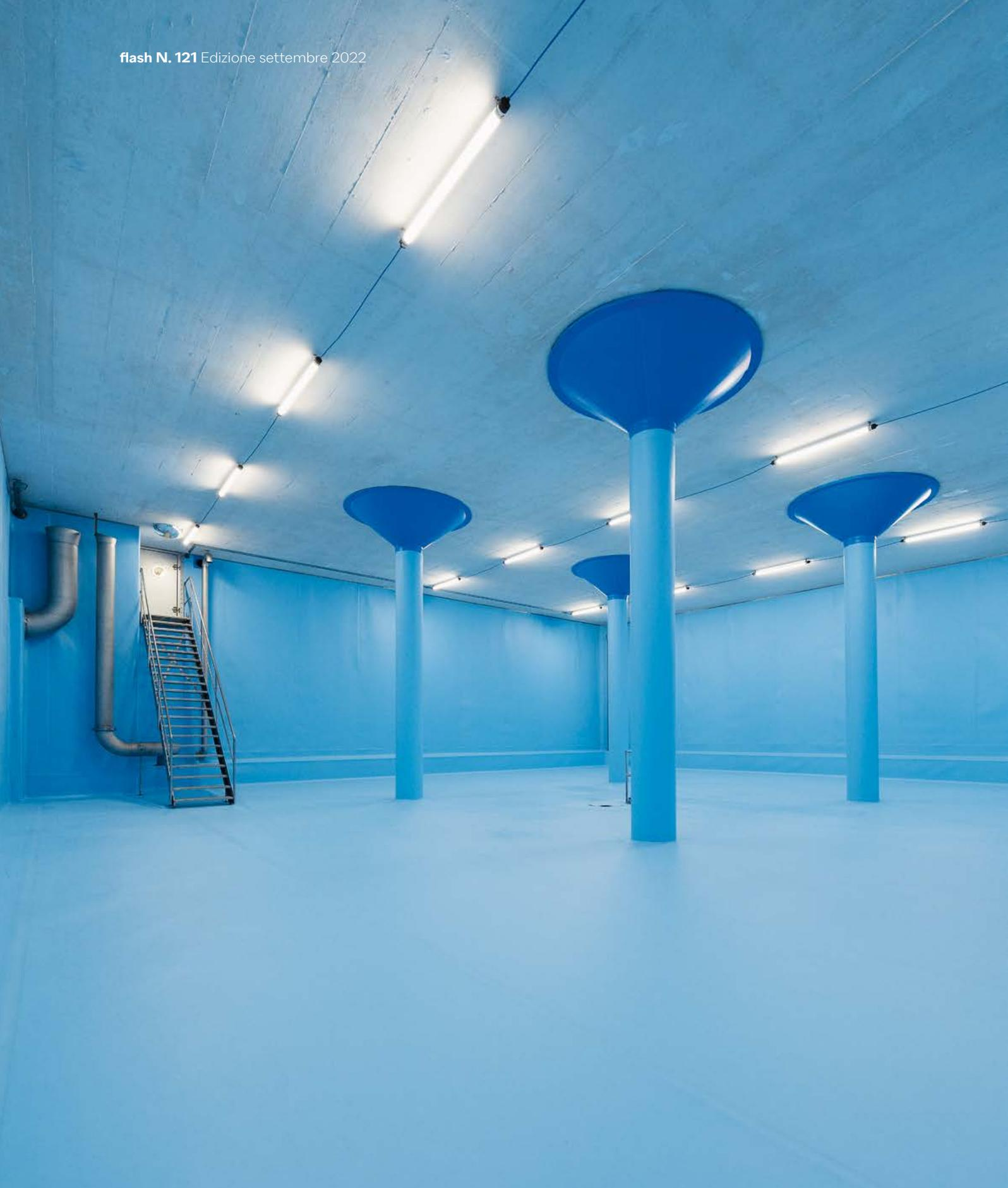
**Imponente:** il serbatoio di acqua potabile del comune di Oensingen è stato riqualificato e può ora immagazzinare 2.400 m<sup>3</sup> di acqua – la capacità delle due camere è stata aumentata di 400 m<sup>3</sup> ciascuna.
