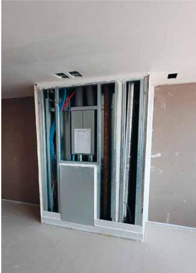
Les modules de technique de bâtiment préfabriqués permettent de réduire considérablement les temps de montage sur site.
