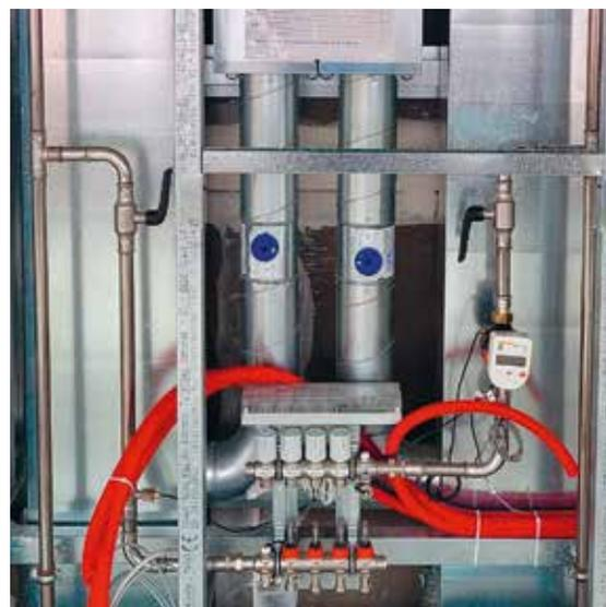
Les modules ont été équipés d'appareils de mesure NeoVac.
