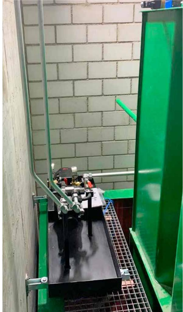
La pompa ad alta pressione del bruciatore verso la caldaia a recupero di calore per la postcombustione.
