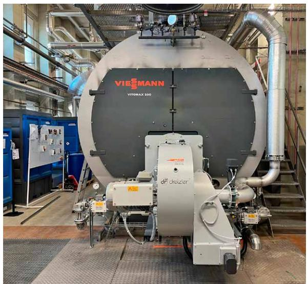
Il generatore di vapore 8 t/h con bruciatore bicombustibile gasolio/gas con impianto automatico a combustione mista di biogas per entrambi i combustibili (pressione del vapore 14 bar).
