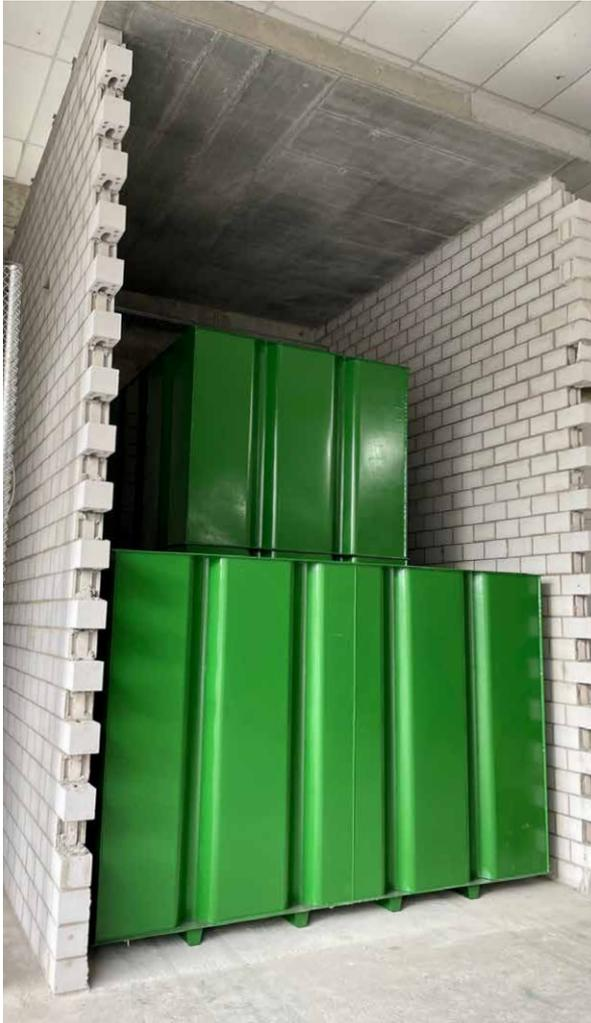
Il nuovo serbatoio cubico di olio combustibile (inclusa la vasca di raccolta) in acciaio ha una capacità di 13'000 litri.
