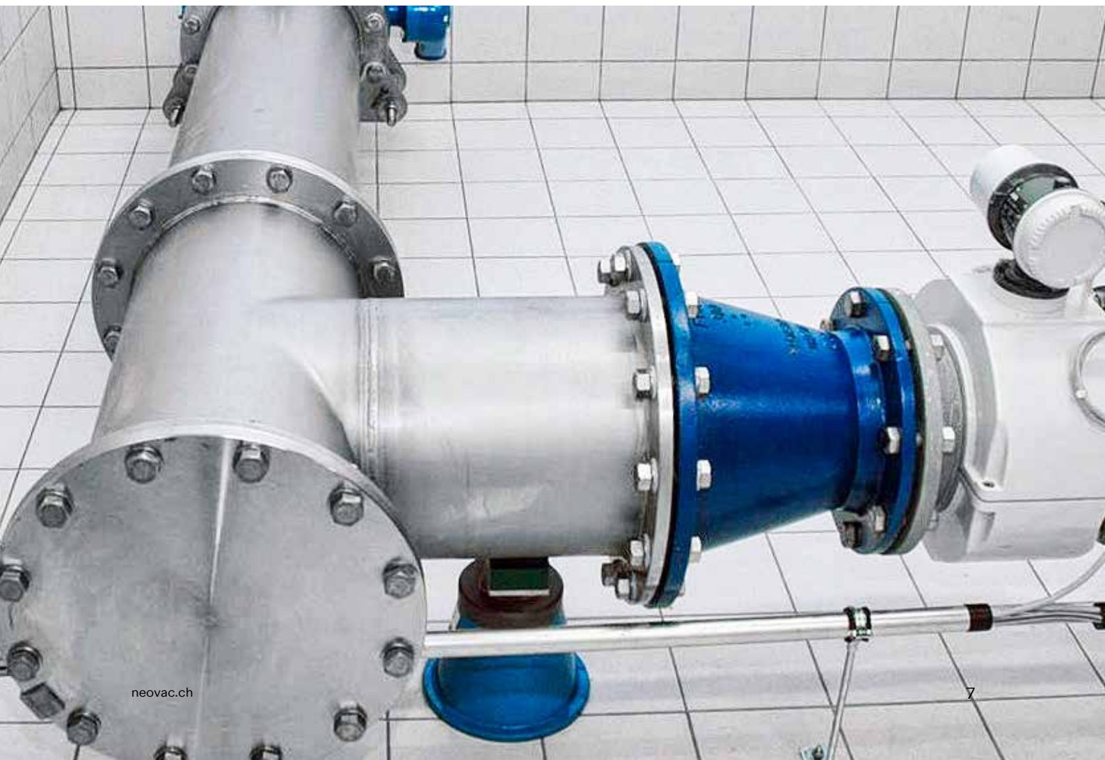
Arrivée avec introduction dans deux chambres à eau ↑ Conduite de prélèvement avec raccordement de réserve ↓
