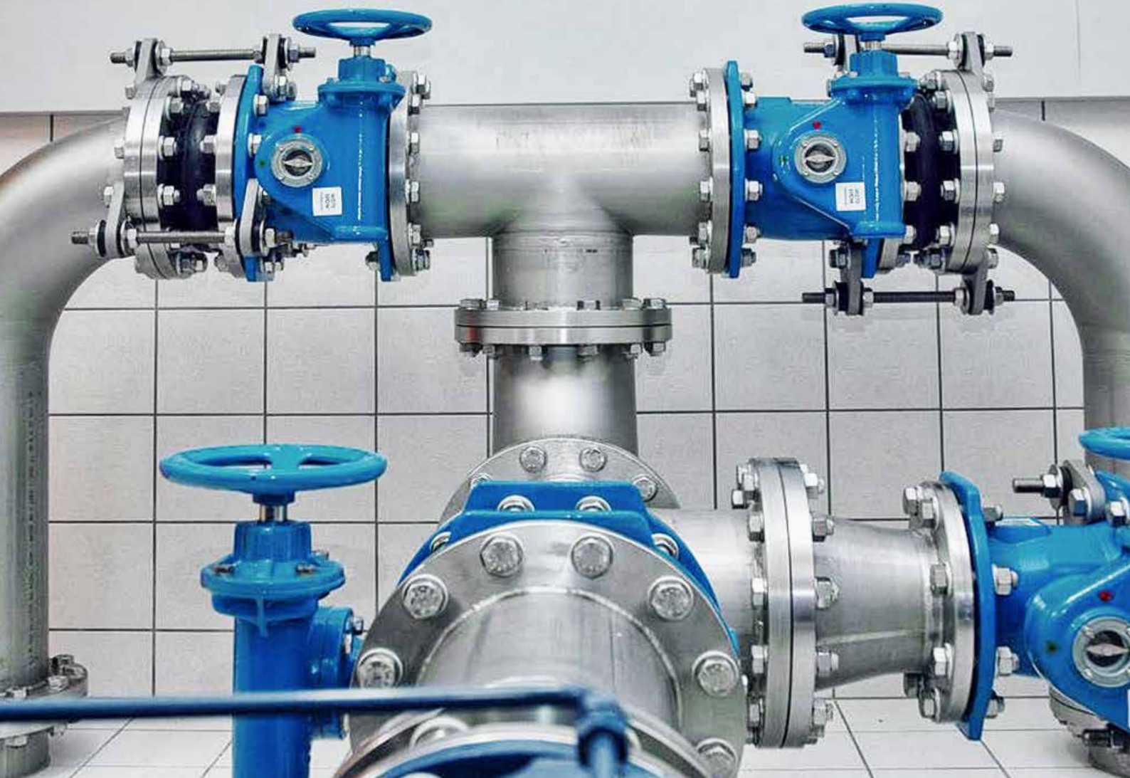
Arrivée avec introduction dans deux chambres à eau ↑ Conduite de prélèvement avec raccordement de réserve ↓
